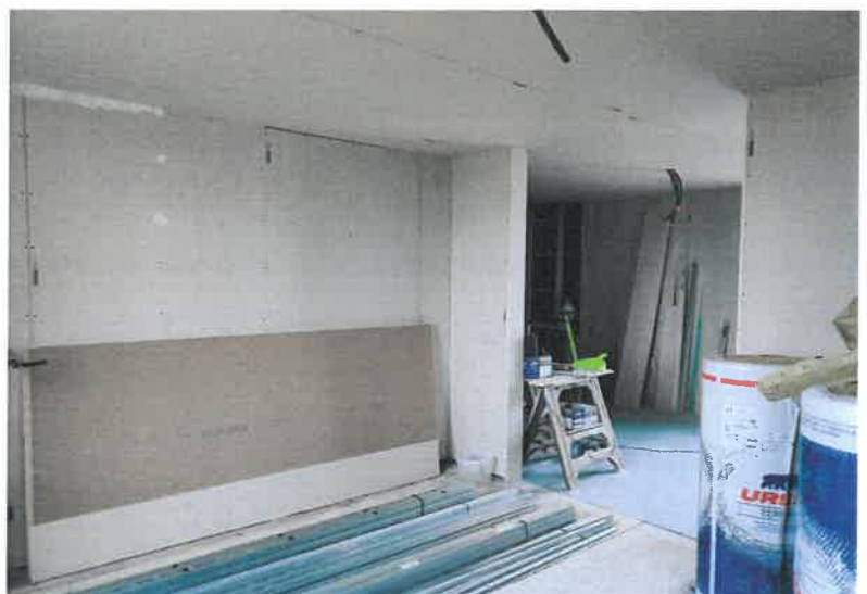
M Perrin (menuisier) aidé d'un laser, pour remettre les plafonds de niveau.
