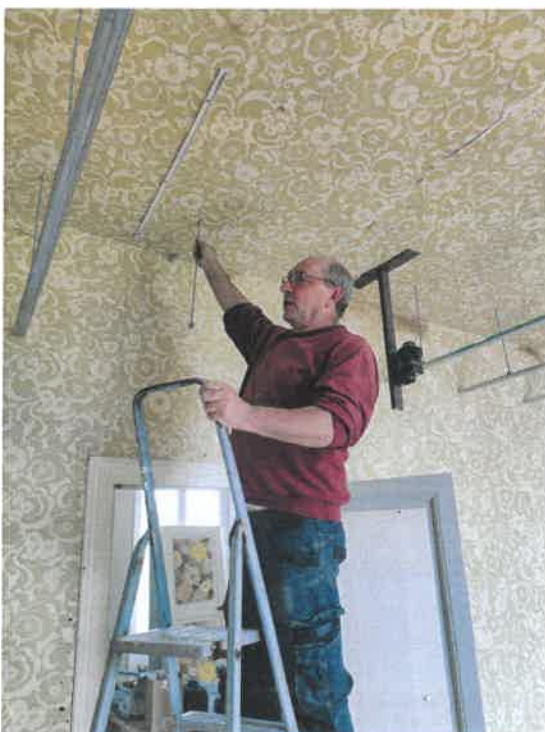
M Perrin (menuisier) aidé d'un laser, pour remettre les plafonds de niveau.
